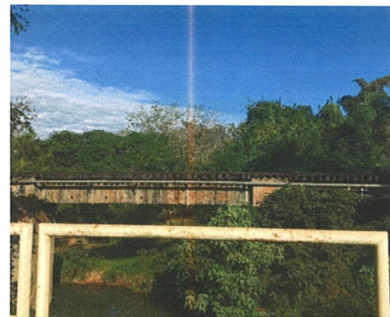
Vista frontal do Pontilhão.
