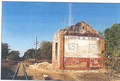
Vista lateral esquerda da Estação Ferroviária em 2003, já em processo de arruinamento.
