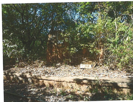
Vista frontal da Ruína
