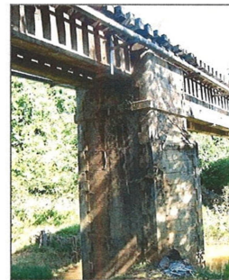
Detalhe de um dos alicerces centrais do pontilhão. IMAGEM: Sofia Cunha, mar/2009.
