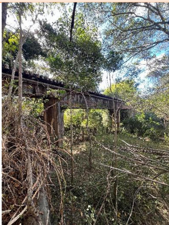
Foto 1: Vista para a tabuleira do pontilhão com trilhos metálicos e dormentes de madeira. Edilson Borges, junho de 2024.
