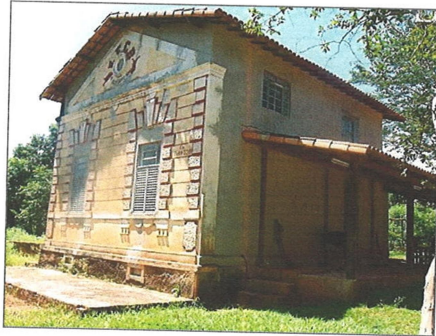
Fachada frontal original, ainda preservada, juntamente com a face lateral esquerda da nova edificação, construída em período recente.
