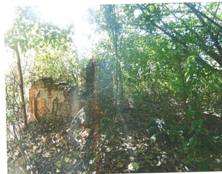
Vista frontal da Ruína
