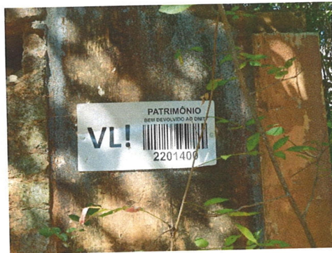
Vista frontal da Ruína
