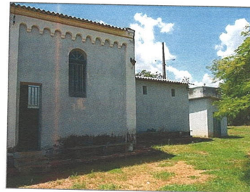
Fachada lateral esquerda.
