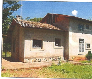
Fachada lateral direita da nova construção.
