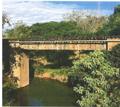
Vista geral do Pontilhão.
