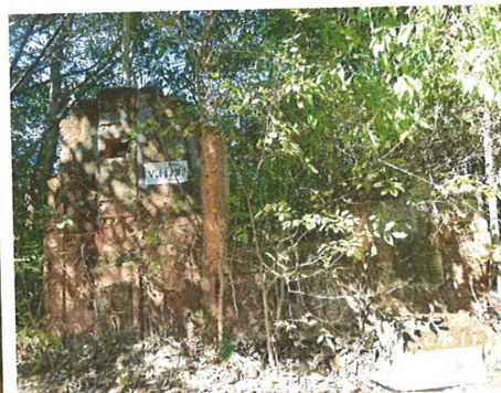
Vista frontal da Ruína
