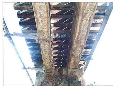
Vista inferior dos trilhos. IMAGEM: Sofia Cunha, mar/2009.
