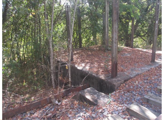
Foto 4: Crescimento de vegetação nas imediações dos remanescentes arquitetônicos da parada. Edilson Borges, junho de 2024.
