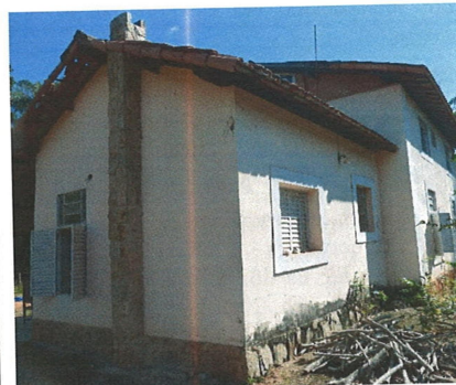
Vista dos fundos do imóvel.
