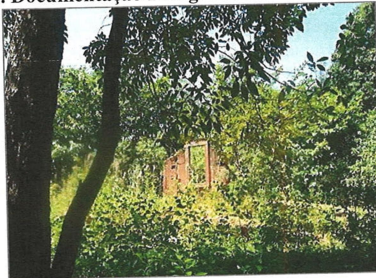
Vista frontal da ruína. IMAGEM: Sofia Cunha, mar/2009.
