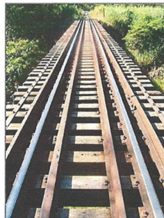
Vista superior dos trilhos.
